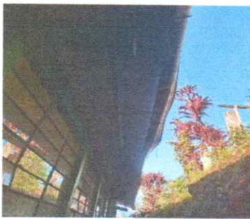
Foto 3: CANALES Y BAJADAS DE AGUA PLUVIAL
