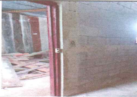
Foto 5: SUSTITUCIÓN DE PUERTA
