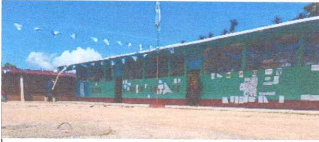
Foto 7: pintura en aulas exteriores e interiores
